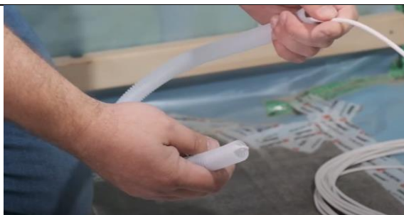
3. Zasuňte senzor s kabelem do chráničky. Senzor musí být v místě vytvořených otvorů.
