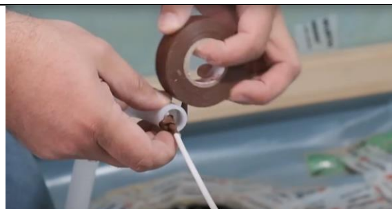
4. Na druhém konci upevněte kabel páskou. Senzor se nebude v chráničce posouvat.
