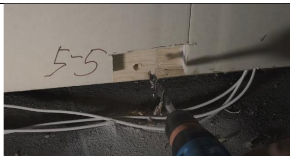
4. Vyvrtní otvoru o průměru 10 mm a hloubce přibližně 20 mm.
