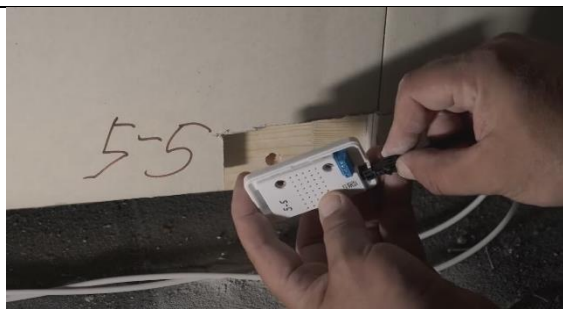
6. Připojte kabel k senzoru.
